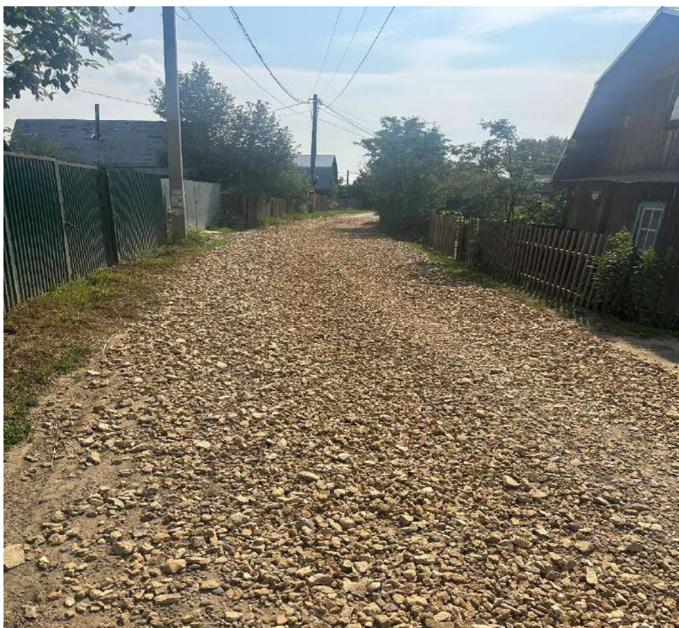
Участок №1038 - №627 после отсыпки щебнем фр.40-70 и фр.20- 40
