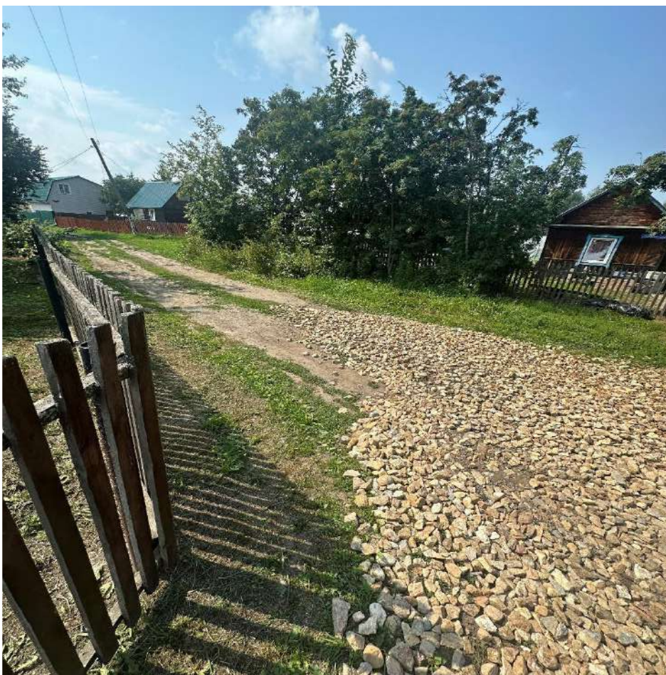
Участок №1524 отсыпка щебнем фр.40-70 и фр.20-40
