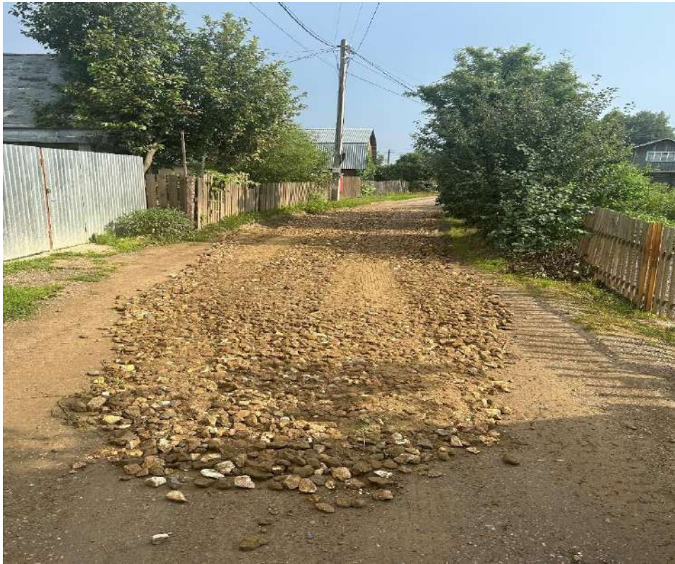
Участок №1038 - №627 после отсыпки щебнем фр.40-70
