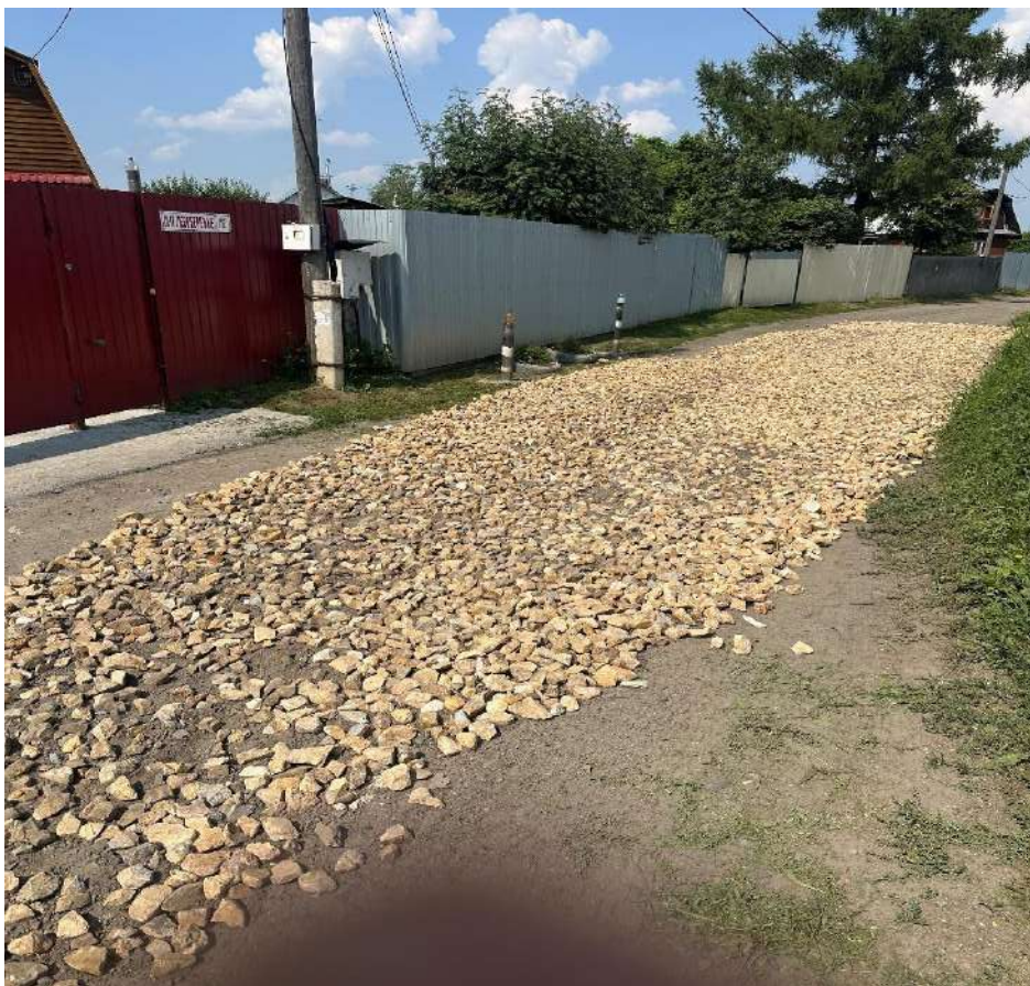
Участок №3827 после отсыпки щебнем фр.40-70
