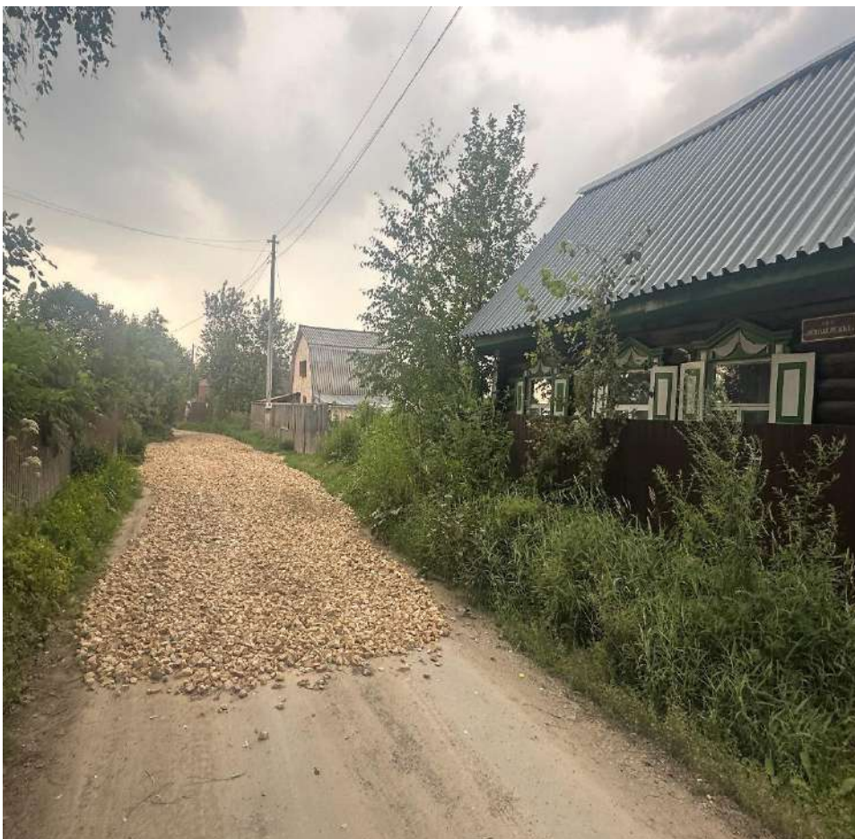
Участок №617 после отсыпки щебнем фр.40-70
