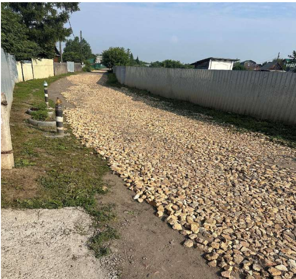
Участок №3827 до участка №3806 отсыпка щебнем фр.40-70
