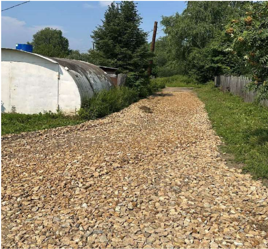
Участок №1104 отсыпка щебнем фр.40-70 и фр.20-40.
