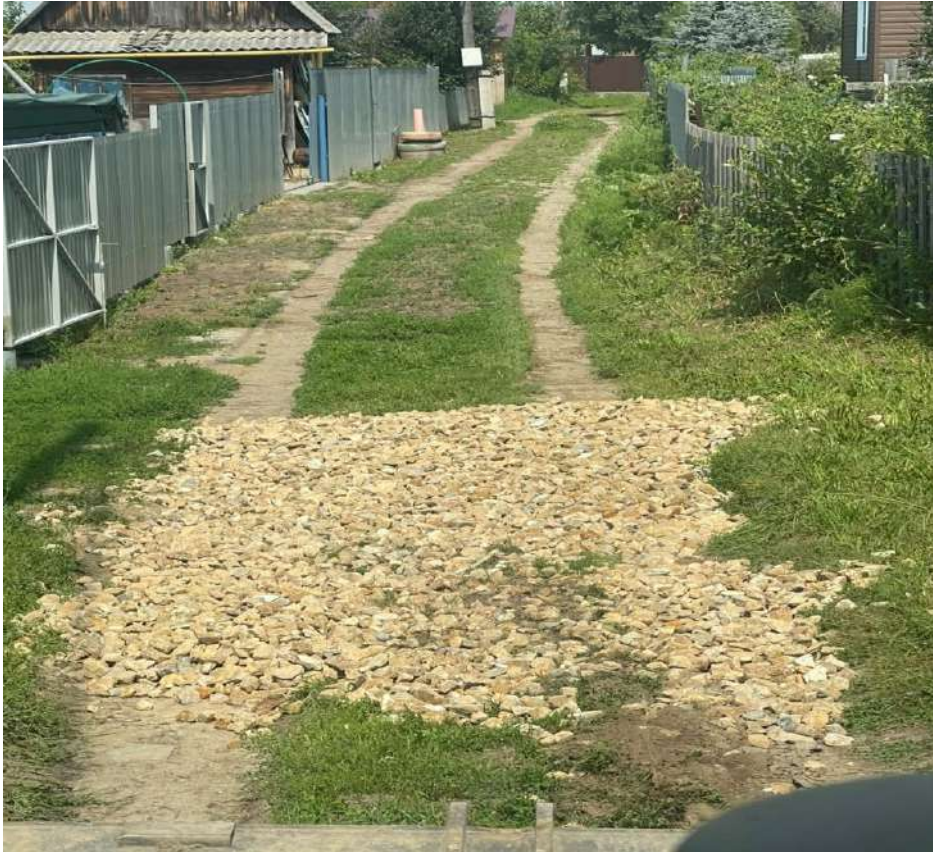
Участок №3904 отсыпка (доп.) щебнем фр.40-70 (1,5 ковша)
