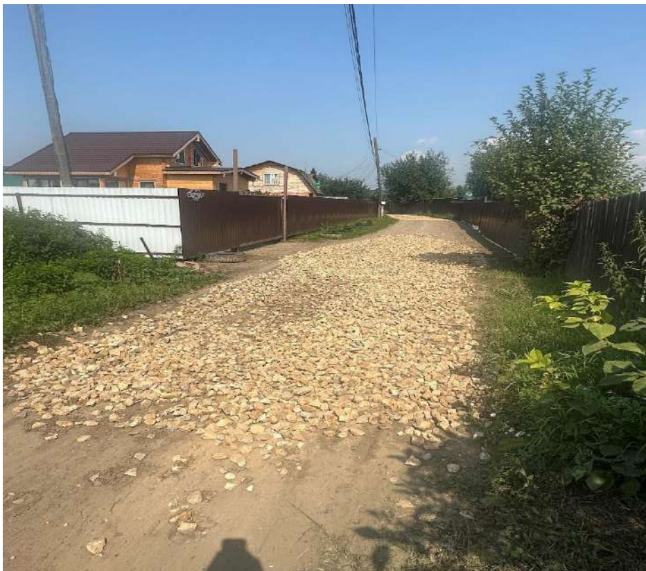
Участок №1610, №1611 отсыпка щебнем фр.40-70
