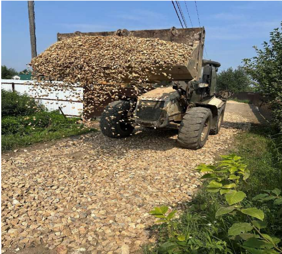
Участок №1610, №1611 отсыпка щебнем фр.40-70 и фр.20-40
