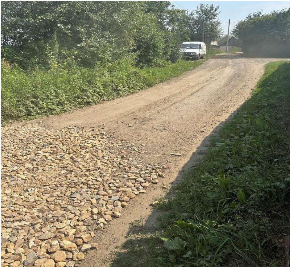
Участок №610, №613 до отсыпки (доп.)
