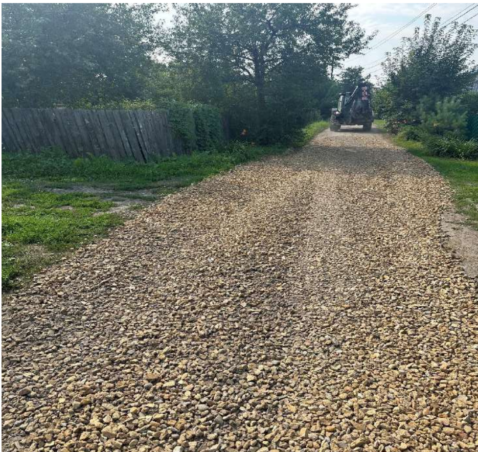
Участок №3421 после отсыпки (доп.) щебнем фр.20-40
