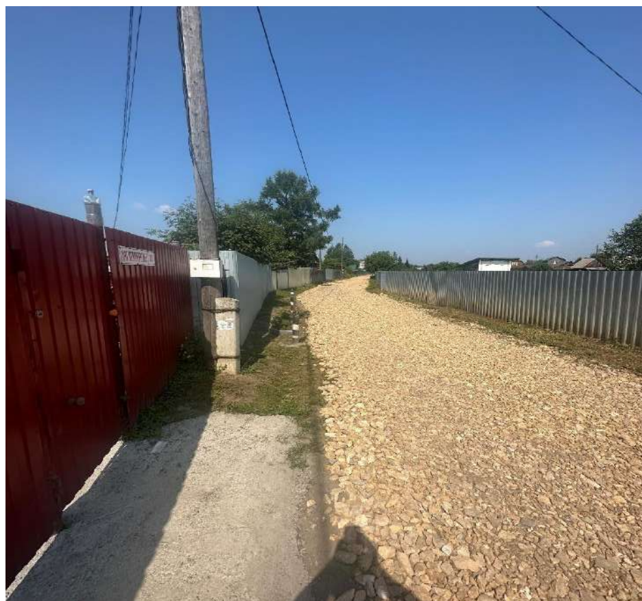
Участок №3827 после отсыпки щебнем фр.40-70 и фр.20-40
