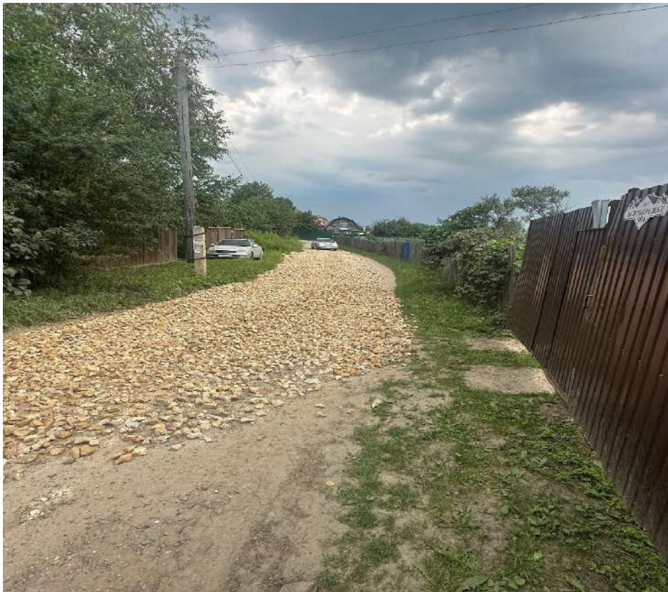
Участок №904 после отсыпки щебнем фр.40-70
