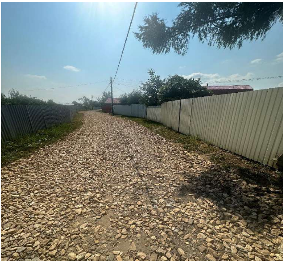
Участок №3810 после отсыпки щебнем фр.40-70 и фр.20-40
