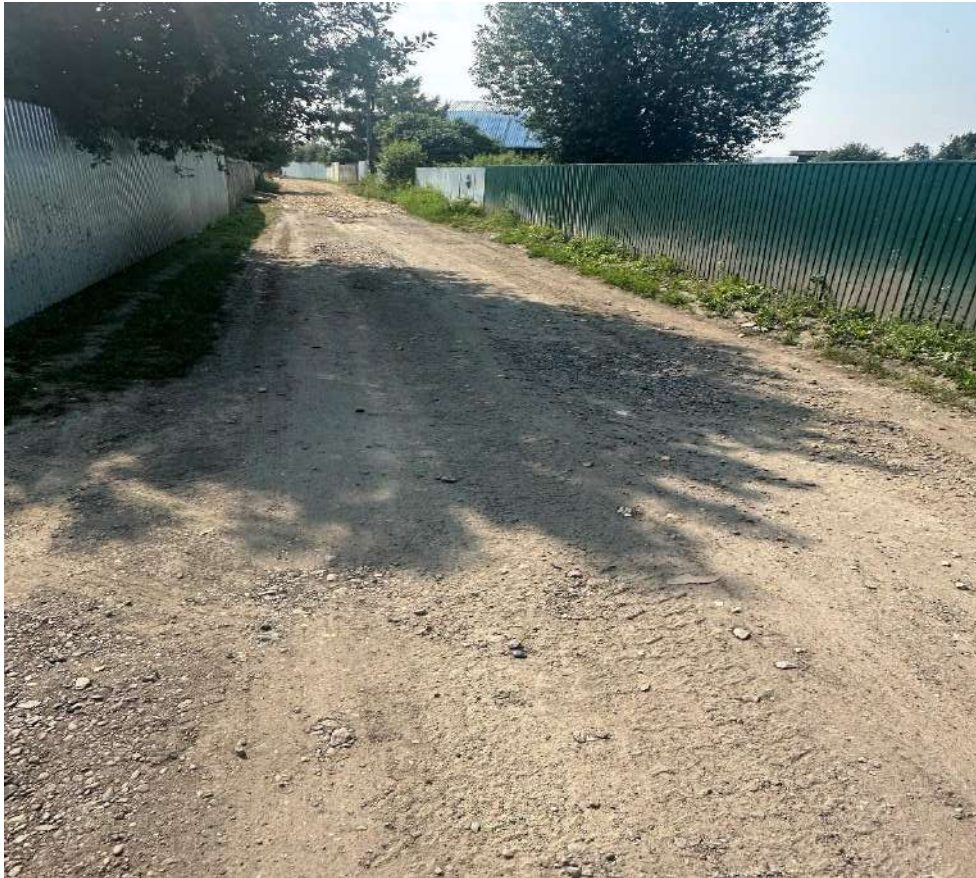
Участок №3901 до отсыпки
