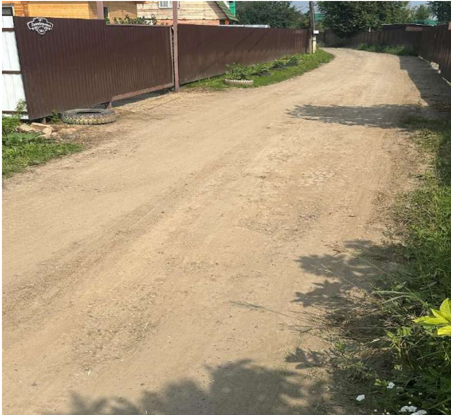
Участок №1611 до отсыпки
