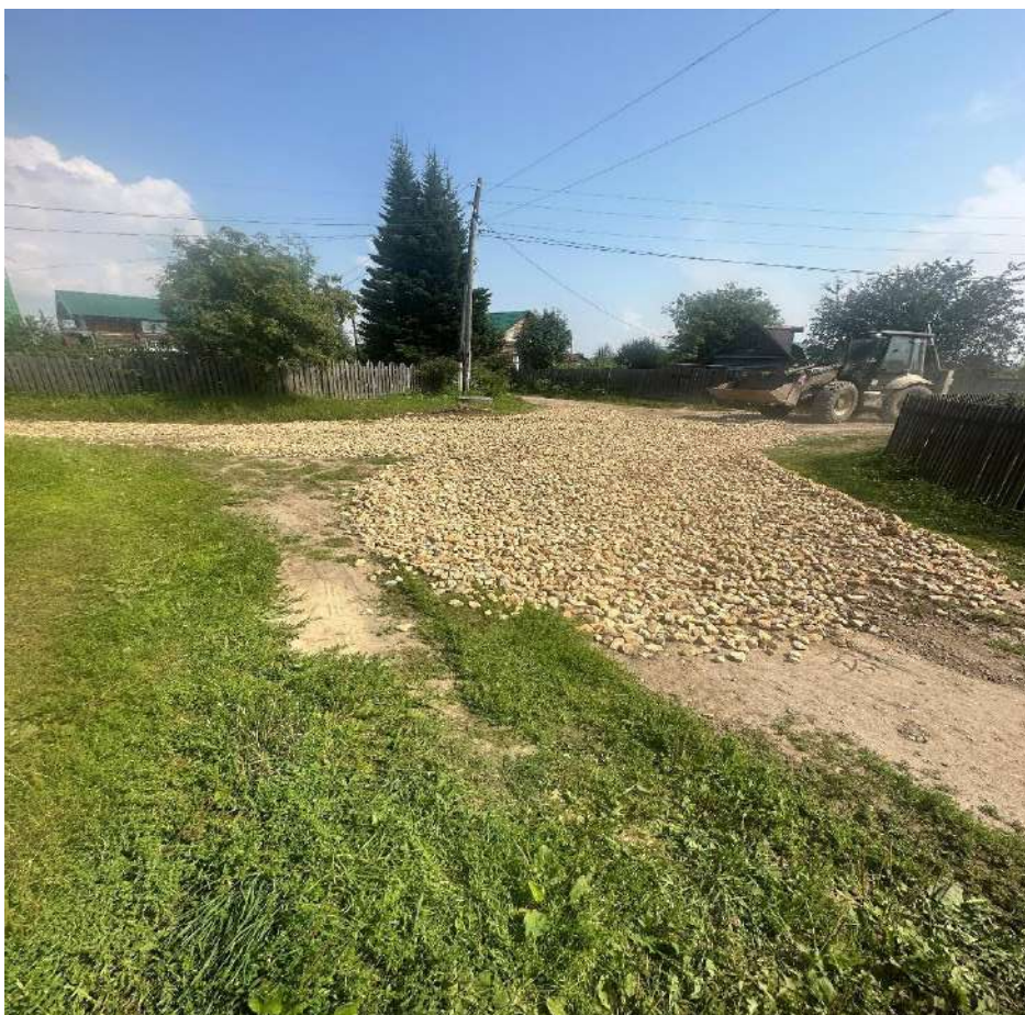
Развилка к участкам №1525, №1805, №1104 отсыпка щебнем фр.40-70
