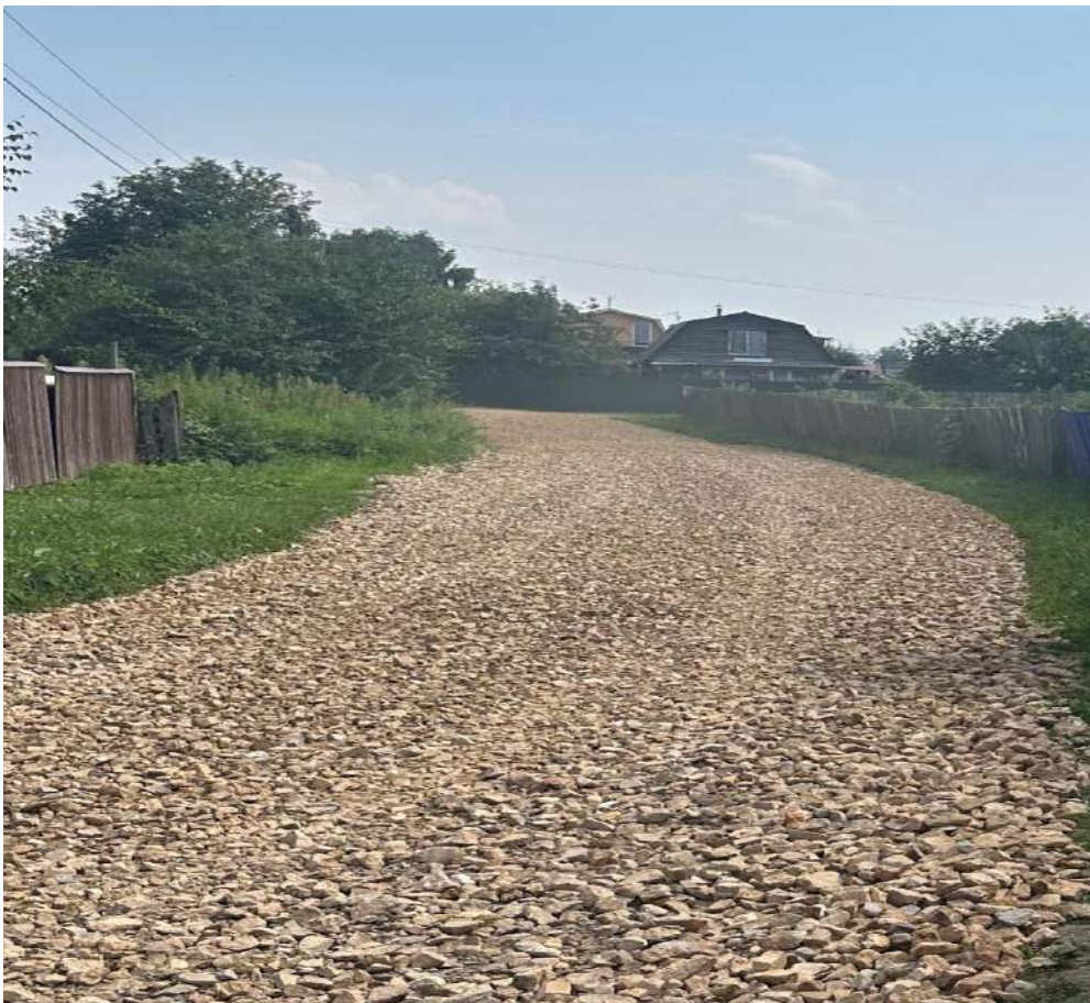
Участок №610, №613 после отсыпки (доп.) щебнем фр.20-40
