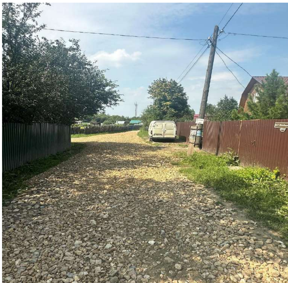
Участок №612, №613 отсыпка щебнем фр.40-70 и фр.20-40 (доп.)
