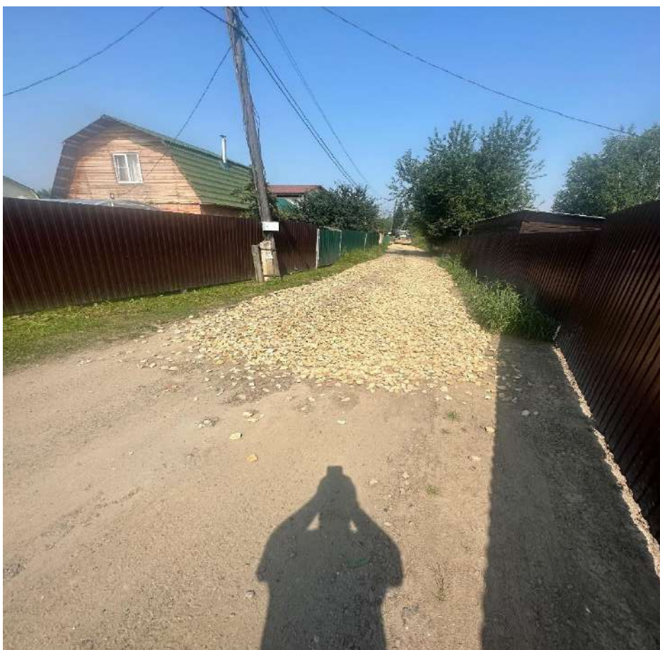
Участок №1613 отсыпка щебнем фр.40-70
