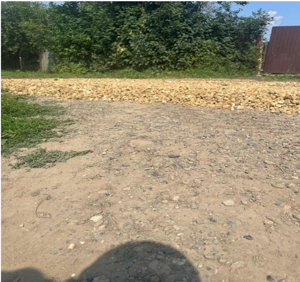
Участок №612 отсыпка (доп.) щебнем фр.20-40
