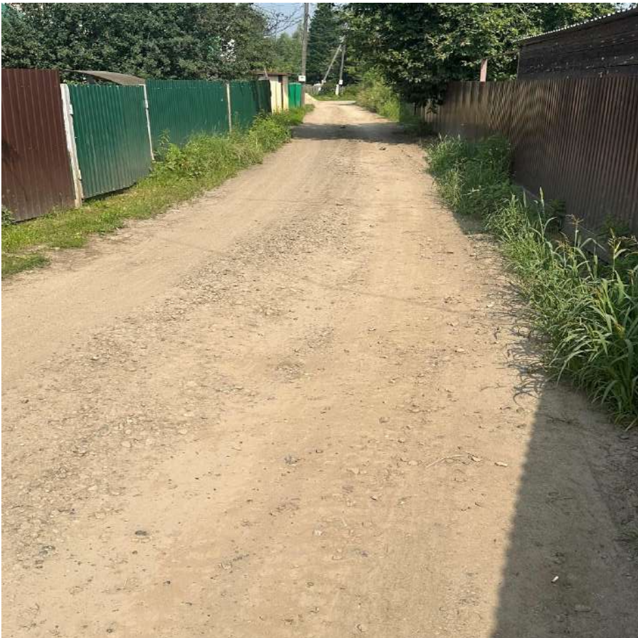
Участок №1613 до отсыпки
