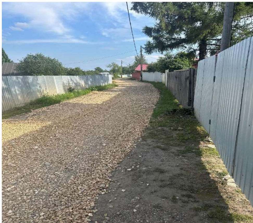
Участок №3809 после отсыпки щебнем фр.40-70 и фр.20-40
