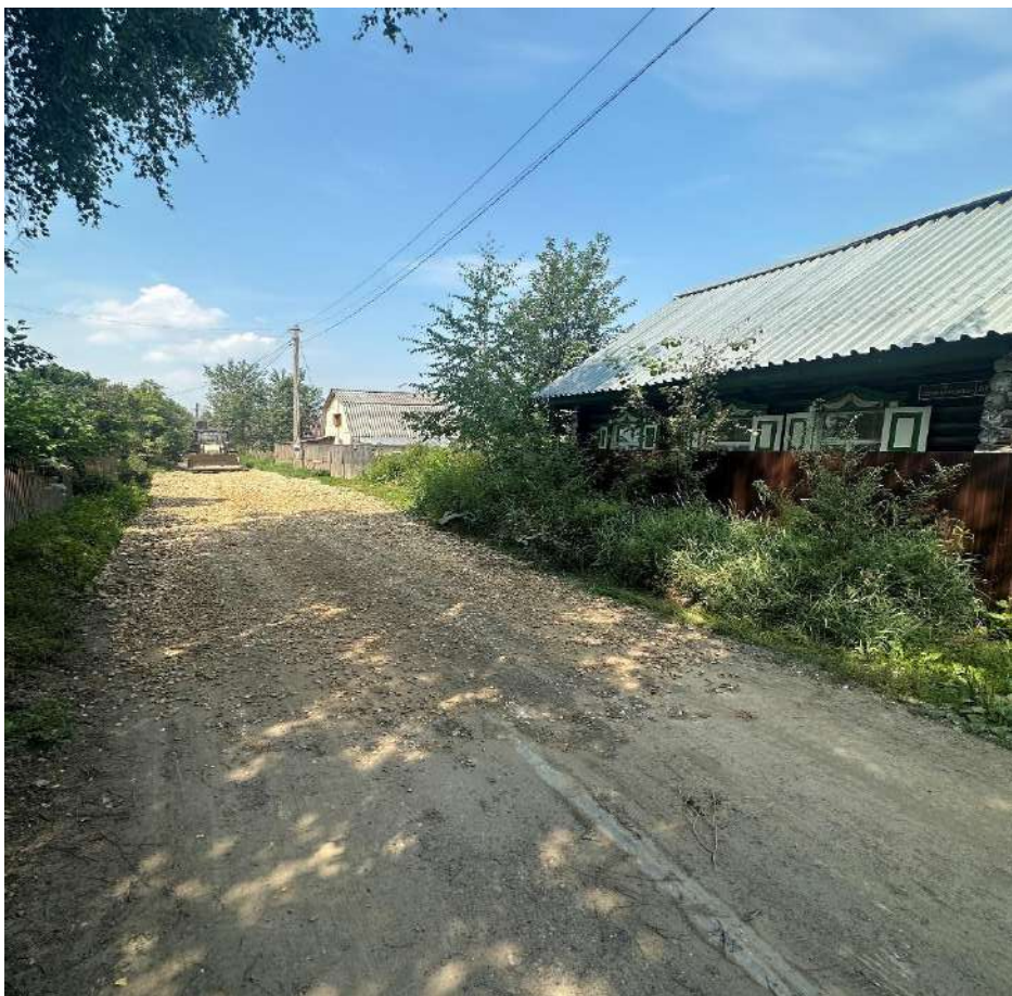
Участок №615, №617 отсыпка щебнем фр.40-70 и фр.20-40
