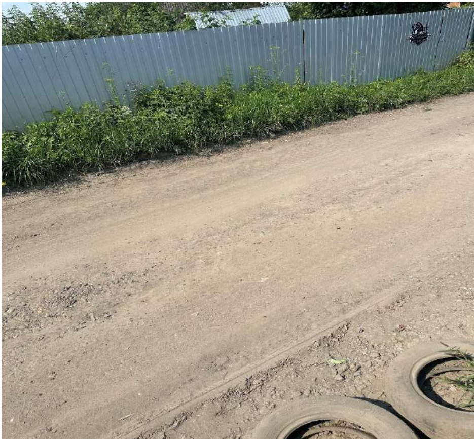
Участок №3806 до отсыпки
