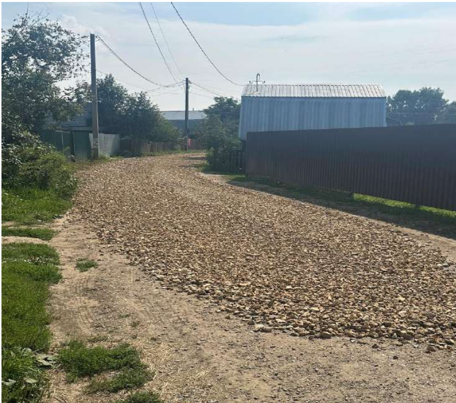
Участок №1039 отсыпка (доп.) щебнем фр.20-40
