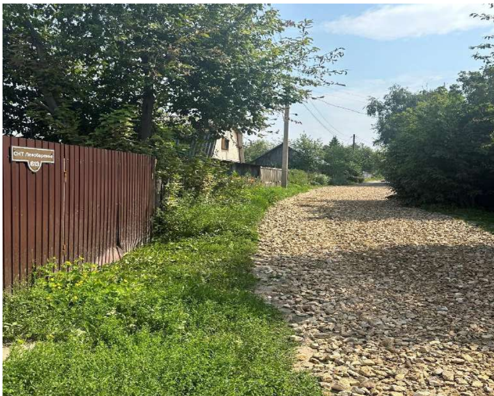
Участок №615, №613 отсыпка щебнем фр.40-70 и фр.20-40
