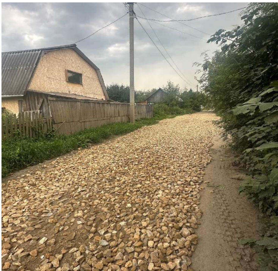
Участок №615 после отсыпки щебнем фр.40-70
