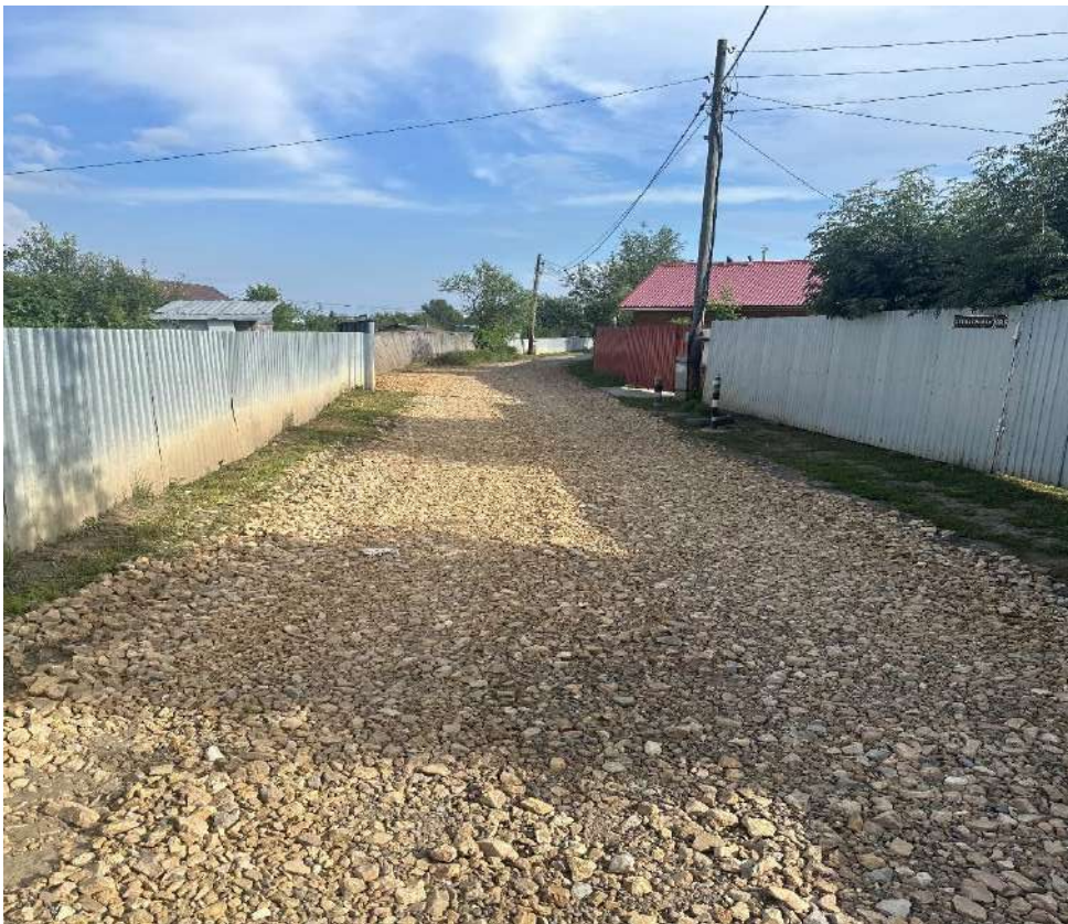
Участок №3811 после отсыпки щебнем фр.40-40 и фр.20-40
