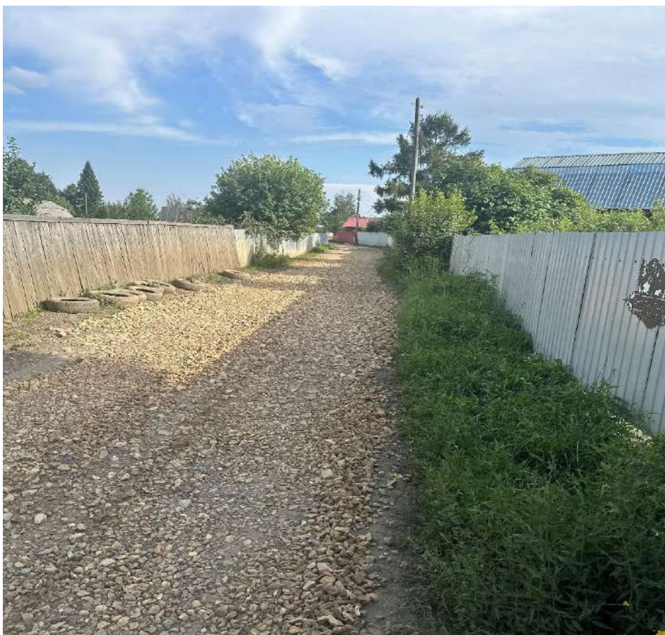
Участок №3806 после отсыпки щебнем фр.40-70 и фр.20-40
