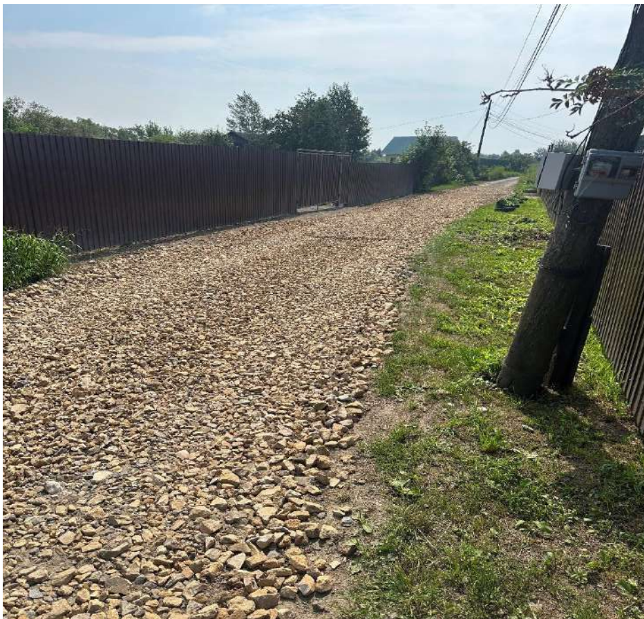
Участок №1610, №1611 отсыпка щебнем фр.40-70 и фр.20-40
