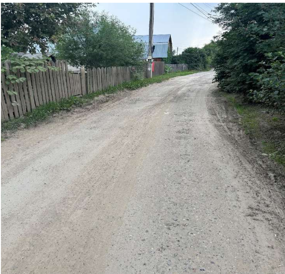
Участок №627 до Участка №1038 до отсыпки щебнем
