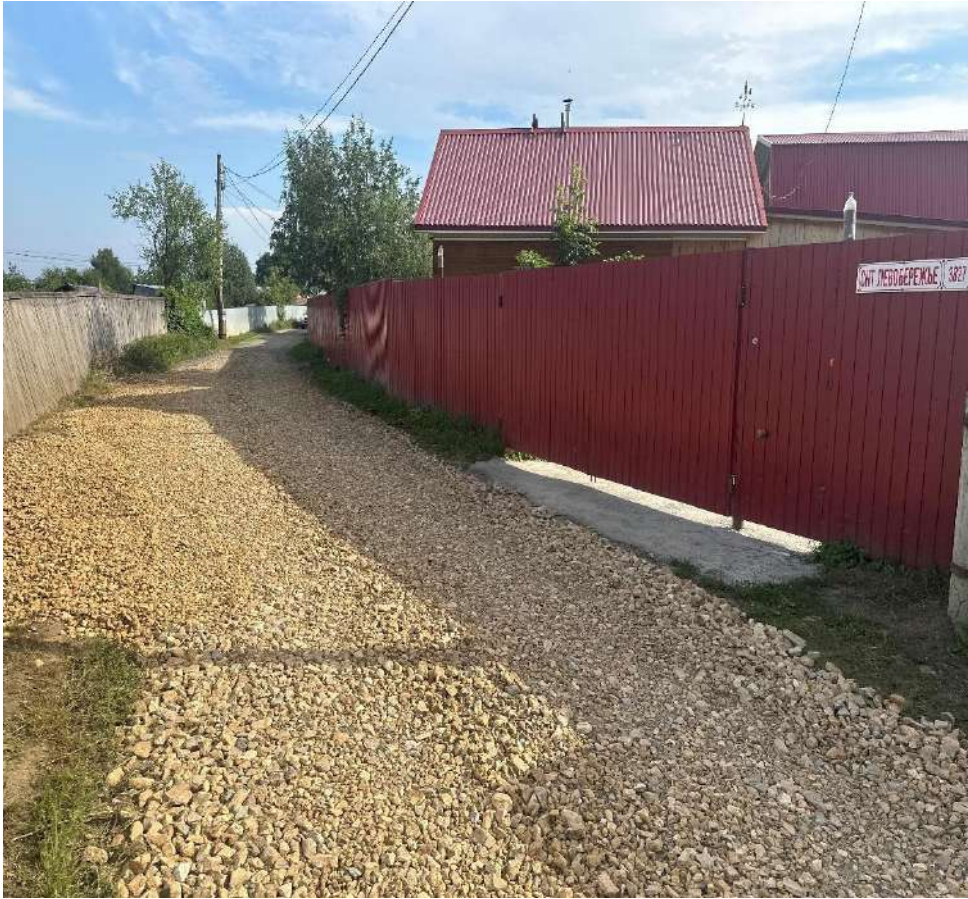
Участок №3827 после отсыпки щебнем фр.40-70 и фр.20-40 (доп.) к участку №3828
