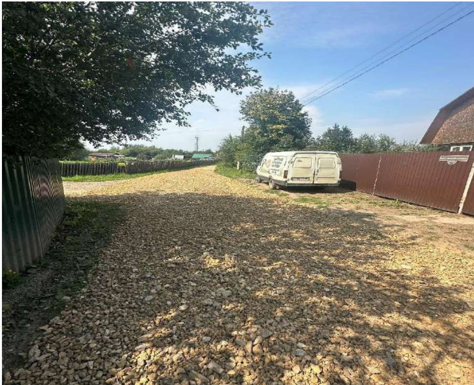
Участок №612 отсыпка щебнем фр.20-40 (доп.)
