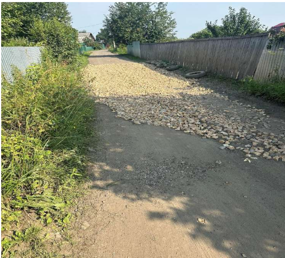
Участок №3806 отсыпка щебнем фр.40-70
