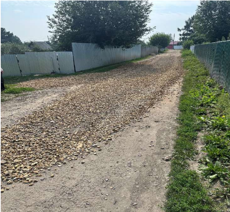
Участок №3901 после отсыпки (доп.) щебнем фр.20-40 (1 ковш к уч.№3901)
