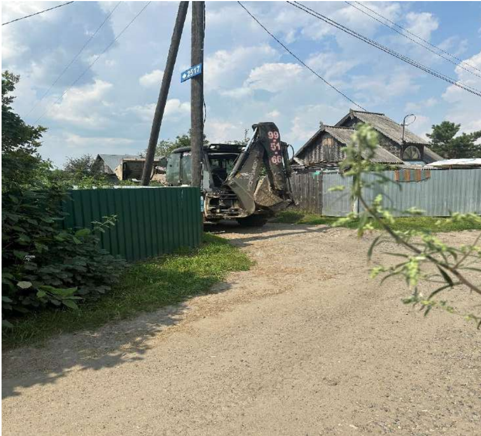
Участок №2604 до отсыпки (доп.
