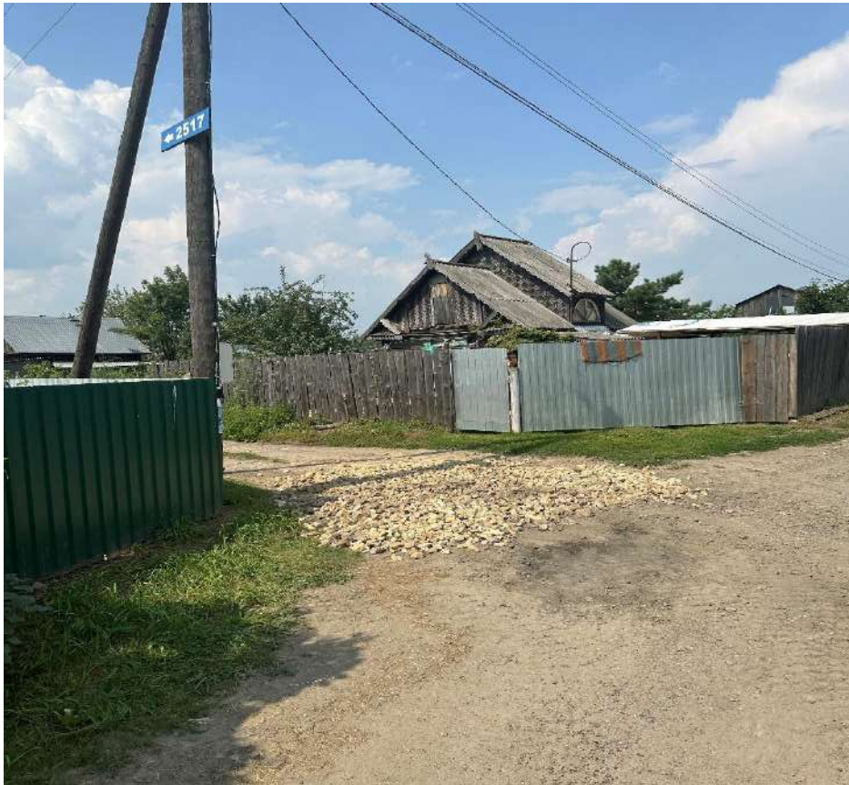
Участок №2604 после отсыпки (доп.) щебнем фр.40-70
