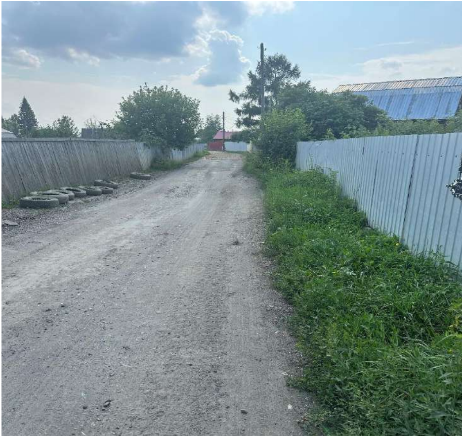
Участок №3806 до отсыпки
