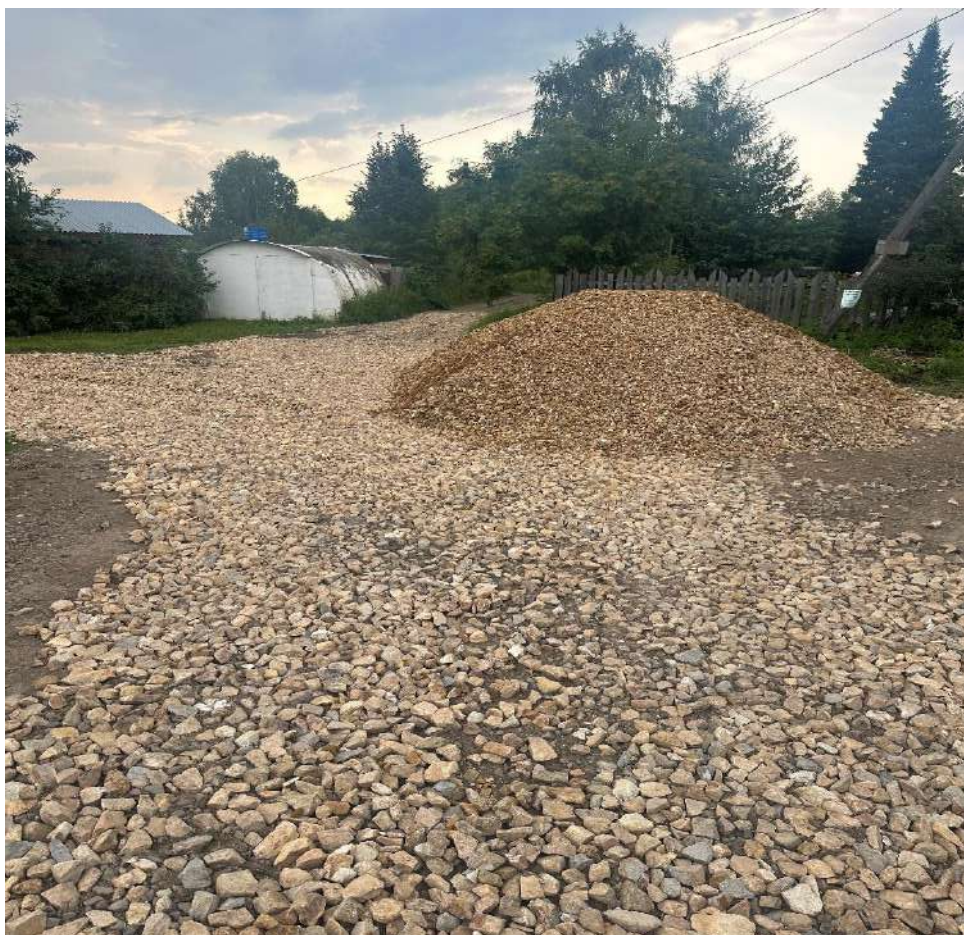
Третья машина. (автомобиль уехал). Щебень фр.20-40
