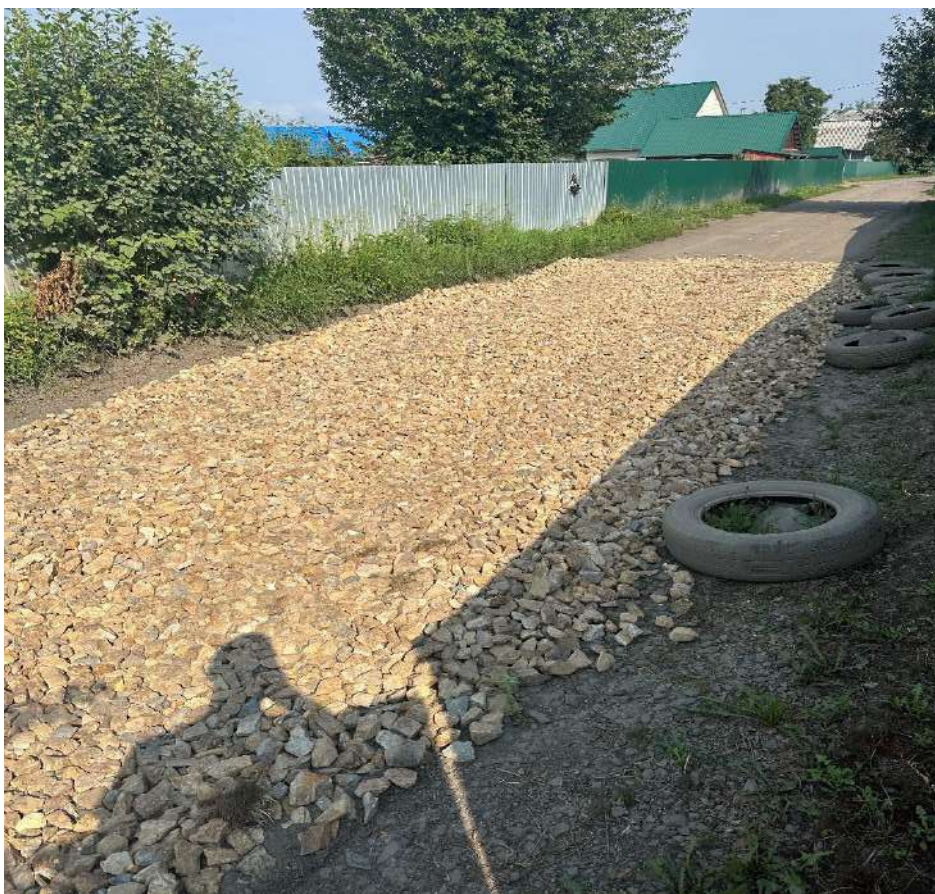
Участок №3806 после отсыпки щебнем фр.40-70
