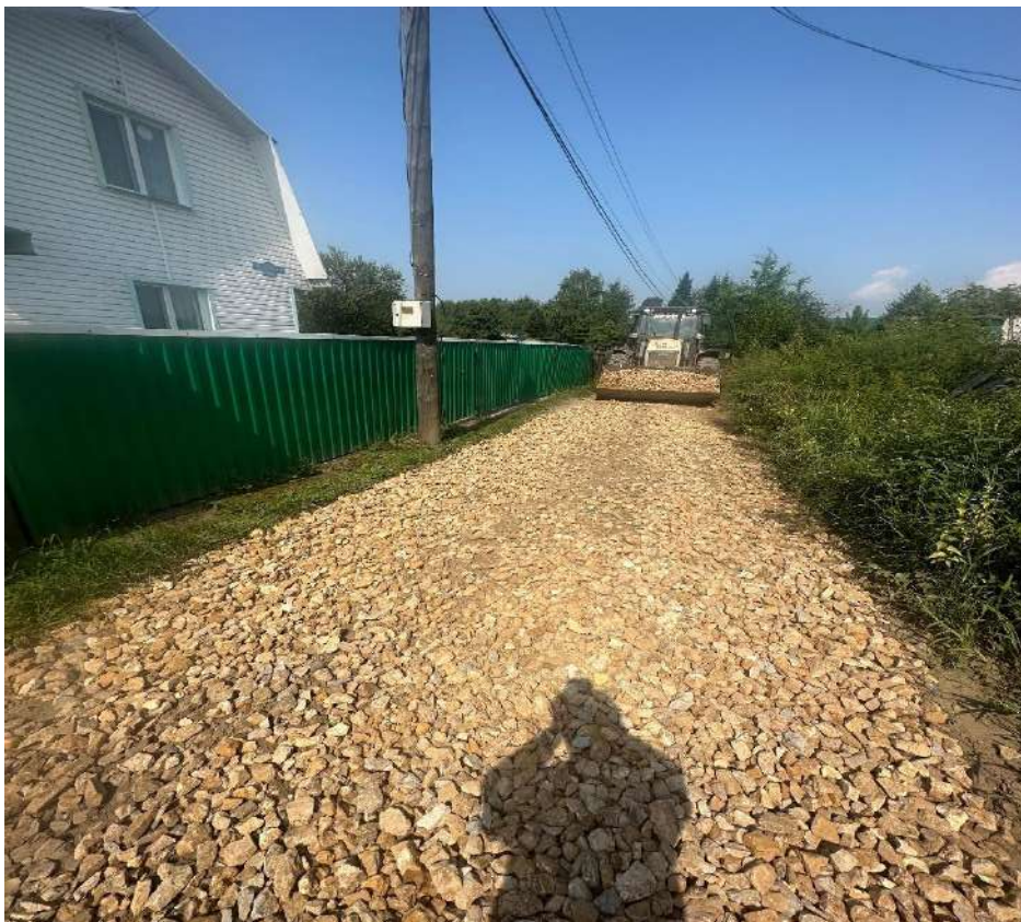
Участок №1601 отсыпка щебнем фр.40-70
