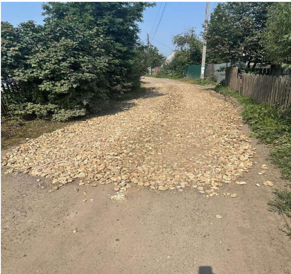
Участок №627 – 1038 после отсыпки щебнем фр.40-70
