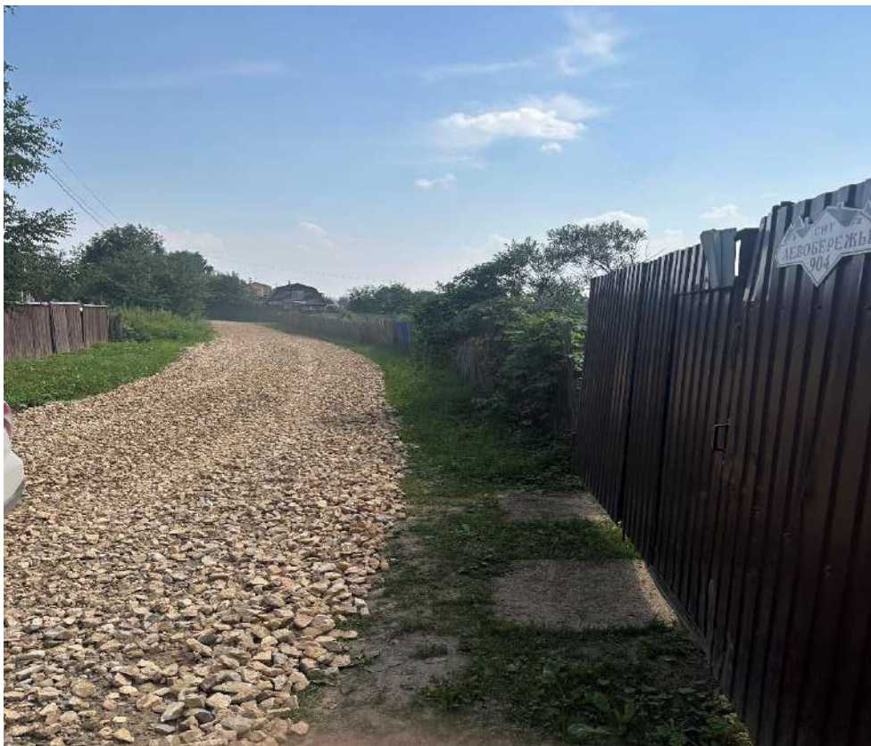
Участок №904 отсыпка щебнем фр.40-70 и фр.20- 40
