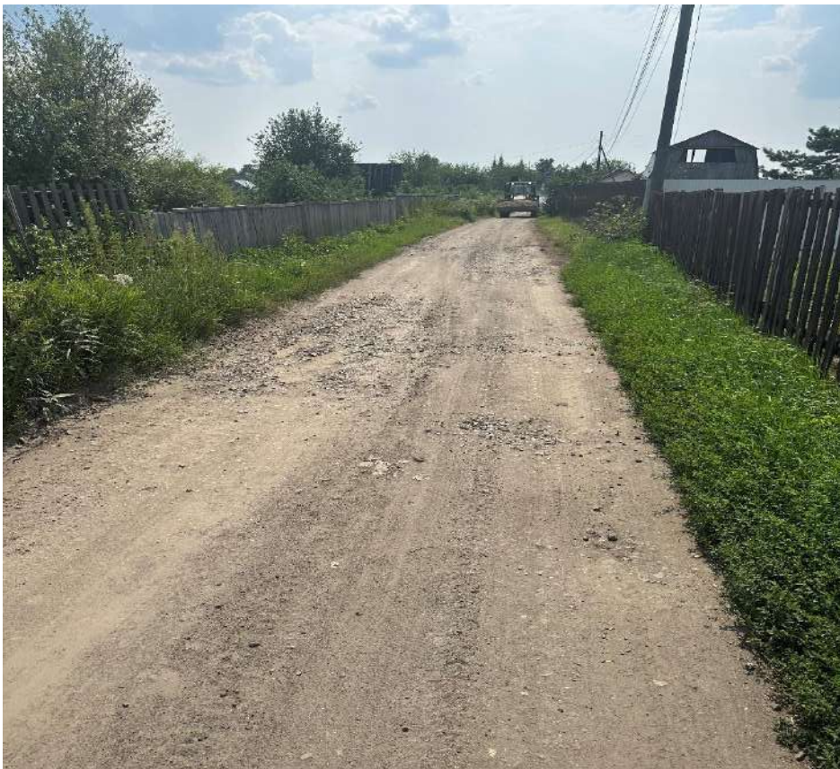
Участок №2604, №2605 до отсыпки
