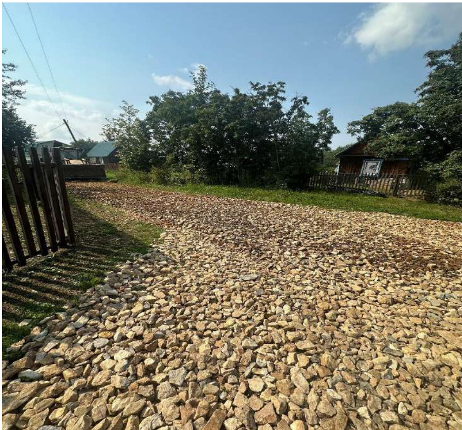
Участок №1524 отсыпка щебнем фр.40-70
