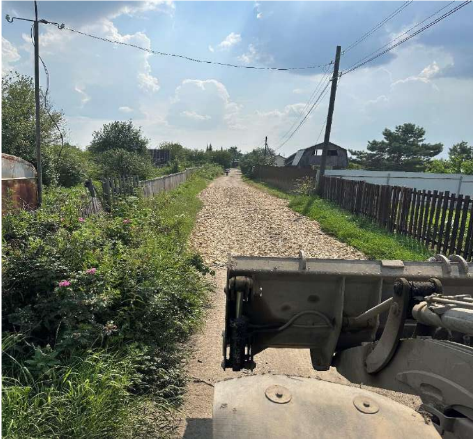
Участок №2604, №2605 после отсыпки (доп.) щебнем фр.40- 70
